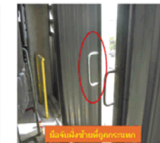
ประตูด้านบนหลุดจากรางบางส่วน
